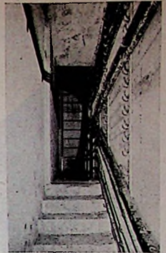
Figuur 13. De leidingtunnel van figuur 12 met overgang van verticaal in horizontaal vlak.
