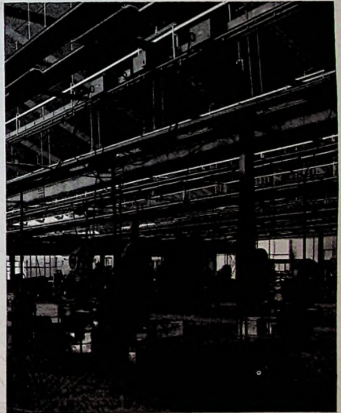
Figuur 14. Bus-Bar-systeem in een fabriekshal te Etten.
